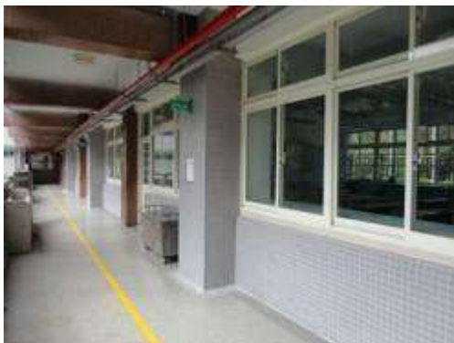
以擴柱工法強化建物結構，提升耐震
