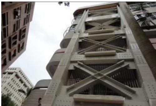
補強工程增添耐震能力
