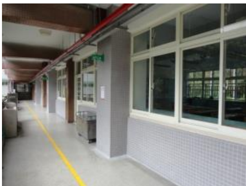
以擴柱工法強化建物結構，提升耐震
